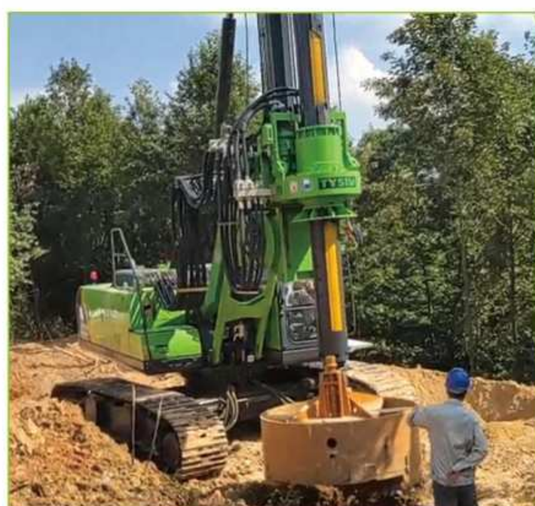
■ Строительство опоры линии электропередачи в Хунане
